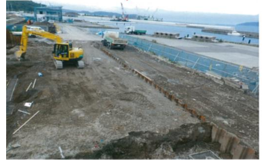
現在は取り壊して 更地に工事中でした！
