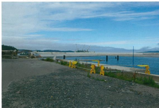
宮古港の防波堤は 新しいコンクリート造りで 修復されていました！
