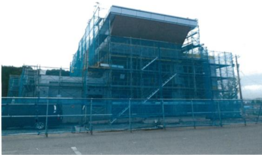
現在 やっと復旧作業に入りました！現在工事中です・・・！
